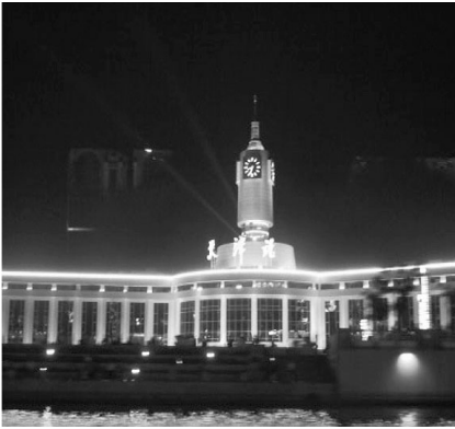
天津市海河東側の天津東駅
