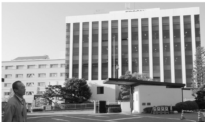
写真2 セイコーエプソン本社
